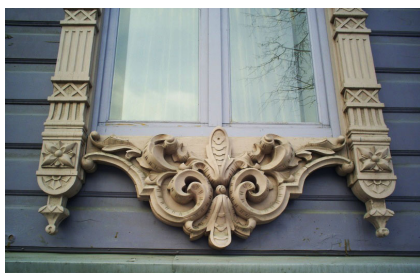
Рис. 8. Сплошные прямоугольные подоконные доски конца XIX–начала XX в. со «свешивающимися» элементами: а — Омск; б — Тюмень; в — Новосибирск
