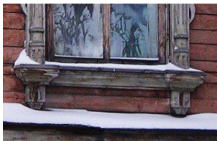
Рис. 5. Подоконные доски конца XIX–начала XX в. с прямым нижним краем: а — Барнаул; б — Тюмень
