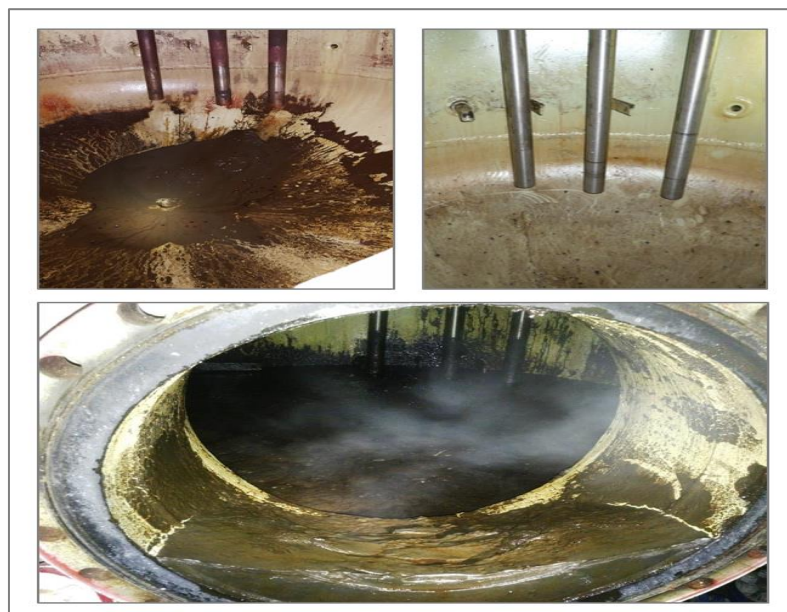
Рисунок 5.1 – Кубовая часть сепаратора с наличием тяжелых углеводородов
