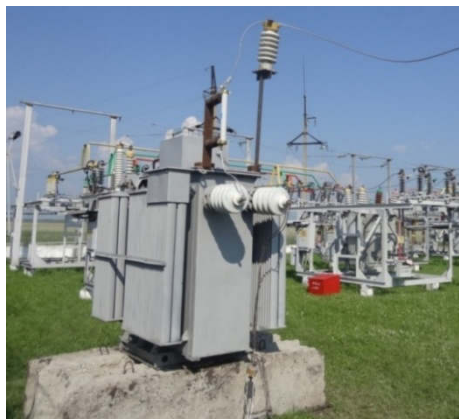
Рисунок 13 – Установка ДГР на подстанции
