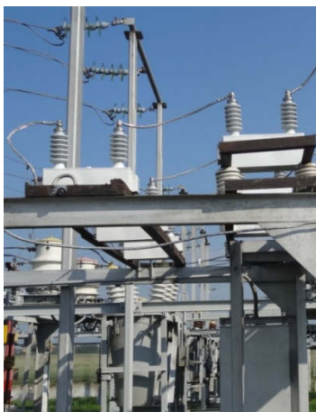
Рисунок 14 – Установка конденсаторов на подстанции при испытаниях
